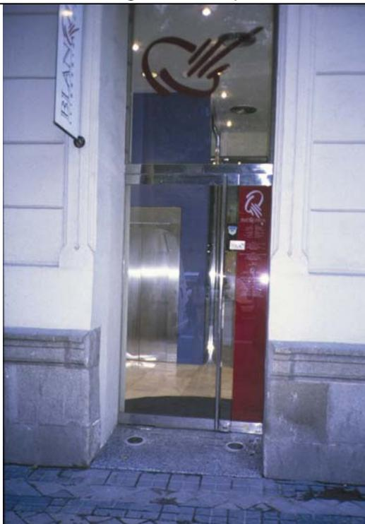
Foto1: Entrada desde el exterior. Falta señalización de la puerta de vidrio
