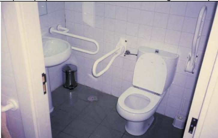
Foto 4: Servicios higiénicos existentes: aunque tienen barras de apoyo, no se puede acceder a ellos por un itinerario accesible ni permiten ser utilizados por usuarios con silla de ruedas.
