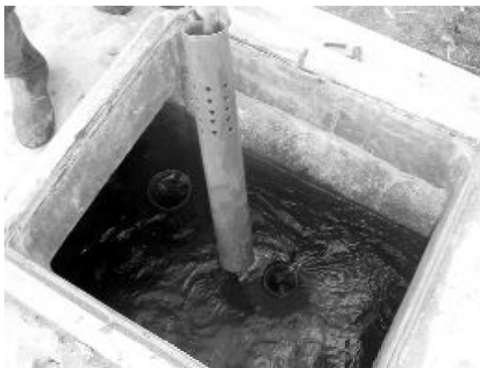
Caja de distribución con orificios, hecha con tubería PVC.
