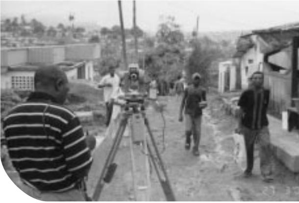
*Ilustración 17. Levantamiento topográfico para la construcción de pistas peatonales y drenajes pluviales en barrios de hábitat espontáneo (Yaundé, Camerún).*
