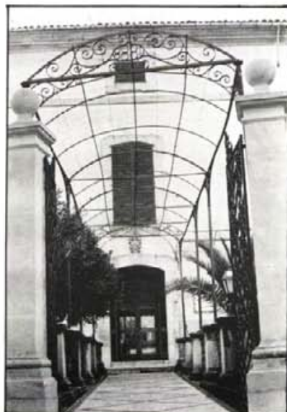
OBRES A LA RESIDENCIA
